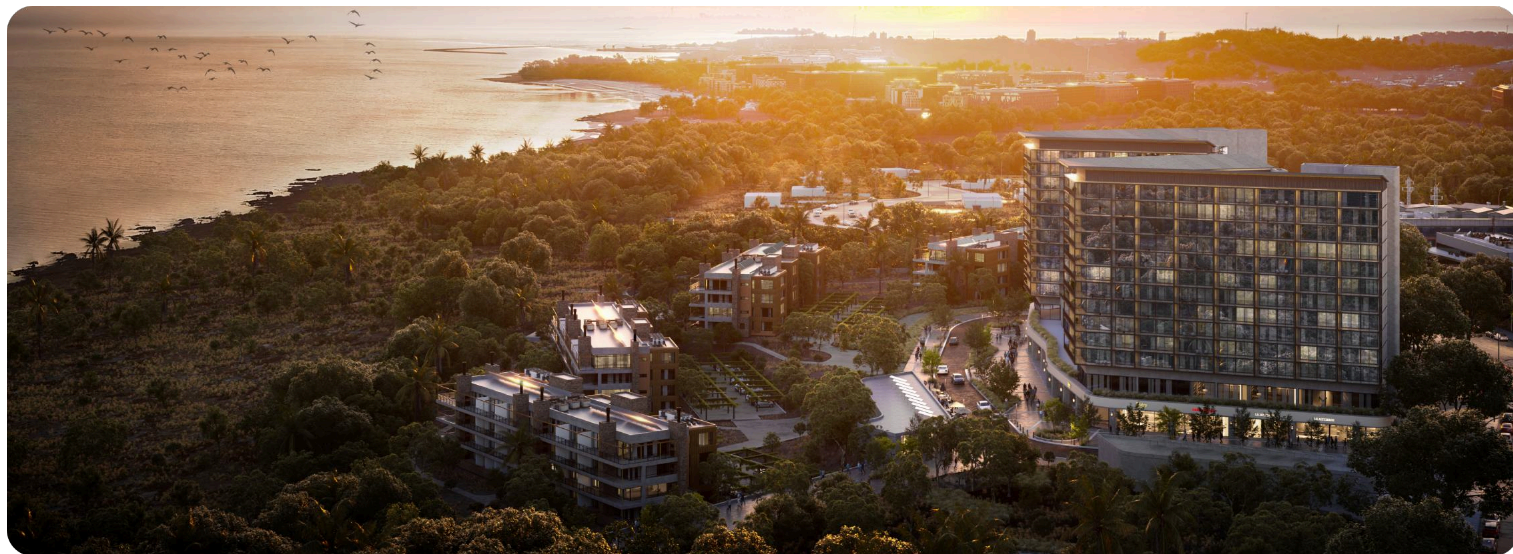
Quartier +Colonia (En obra) Colonia
