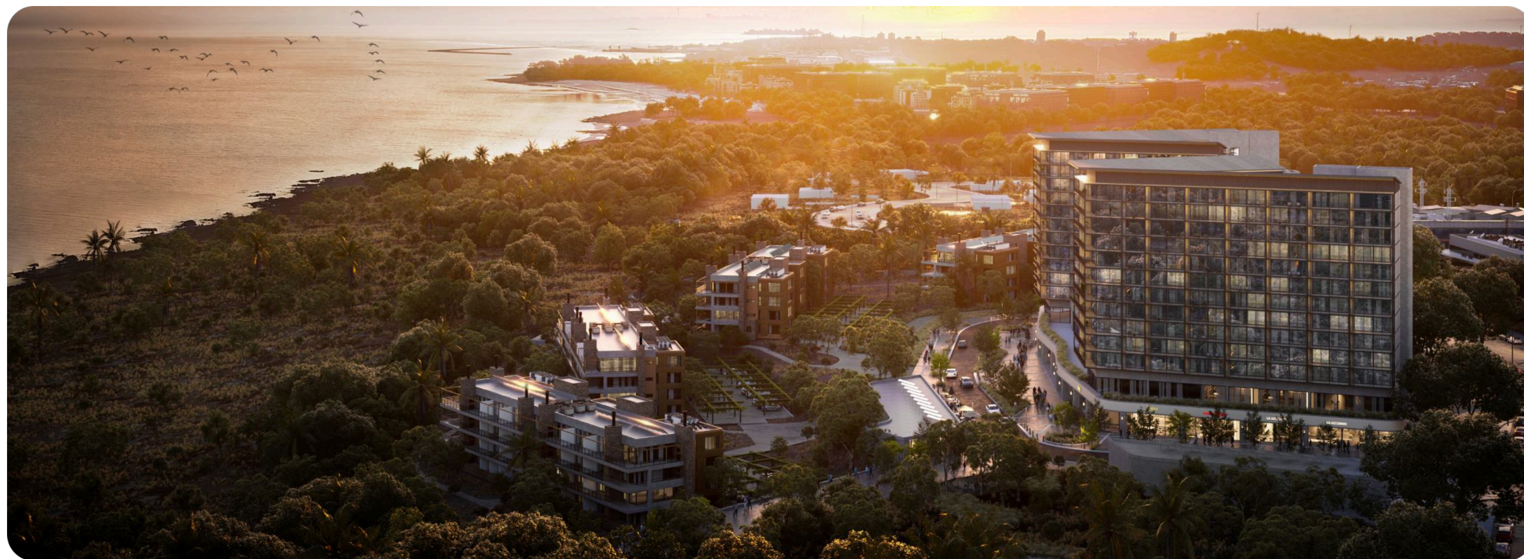
Quartier +Colonia (En obra) Colonia
