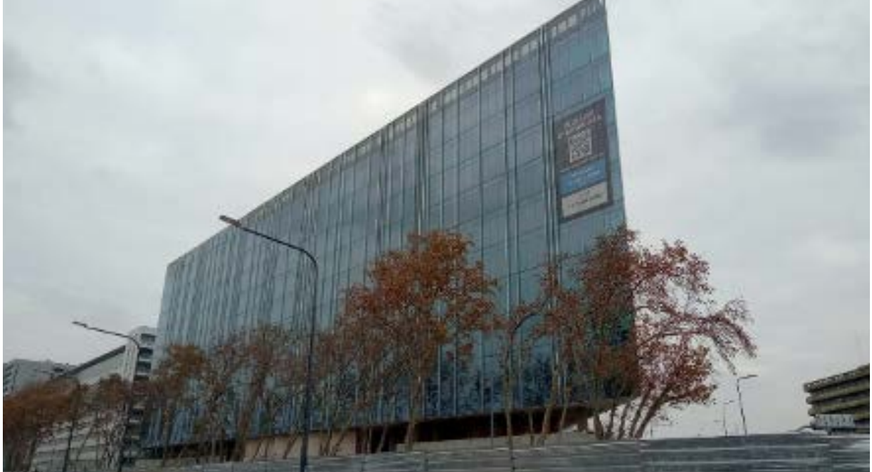
■ Vista exterior sobre Av. Ramón Castillo
