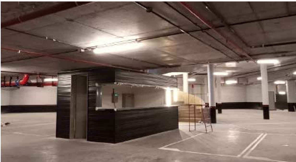
■ Montaje de revestimiento de chapa en caja de 1º Subsuelo – MSH
