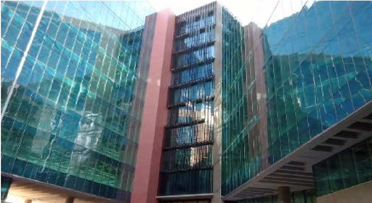
■ Montaje de parasoles en frente de palieres – CARPINTERIAS METALICAS ORLANDO
